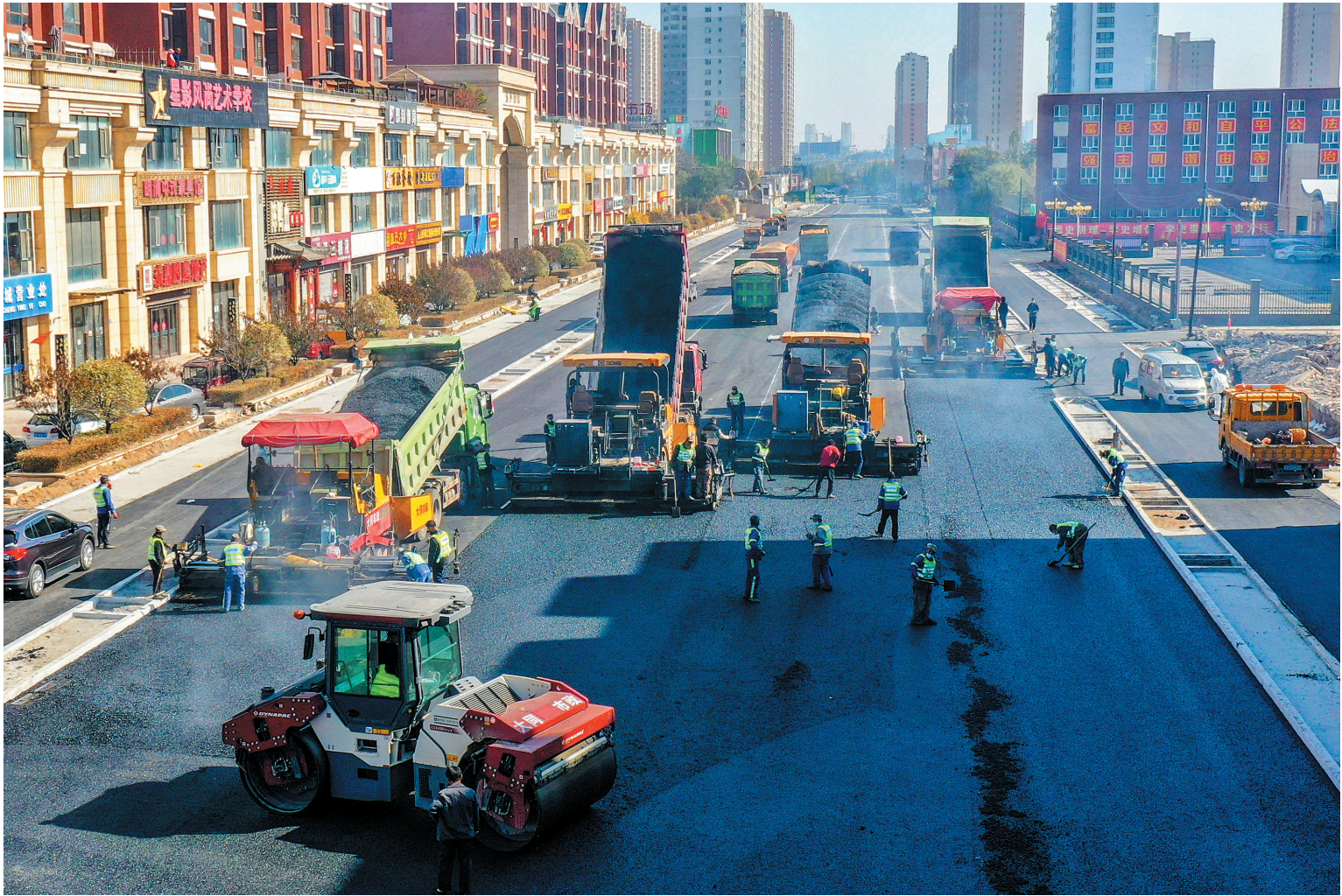
10月19日，操场街道路改造工程开始道路面层沥青摊铺。
