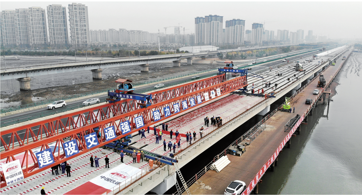
10月30日拍摄的青兰高速公路双埠至河套段女姑口特大桥合龙现场。女姑口特大桥全长3167.5米，横跨胶州湾海域（无人机照片）。
