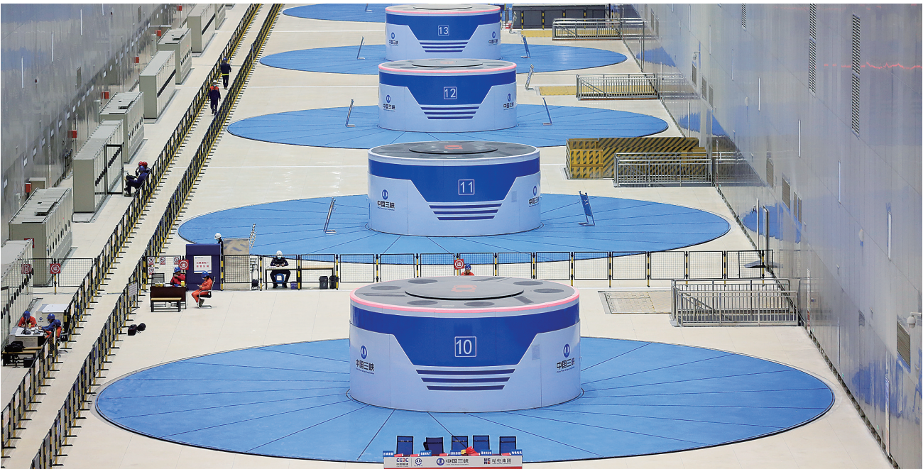
这是11月5日拍摄的白鹤滩水电站右岸地下厂房发电机组。11月5日18时55分，白鹤滩水电站10号机组顺利通过72小时试运行，正式投入商业运行，这是白鹤滩水电站投产发电的第15台百万千瓦水轮发电机组，标志着白鹤滩水电站进入了全面投产发电的最后冲刺阶段。
