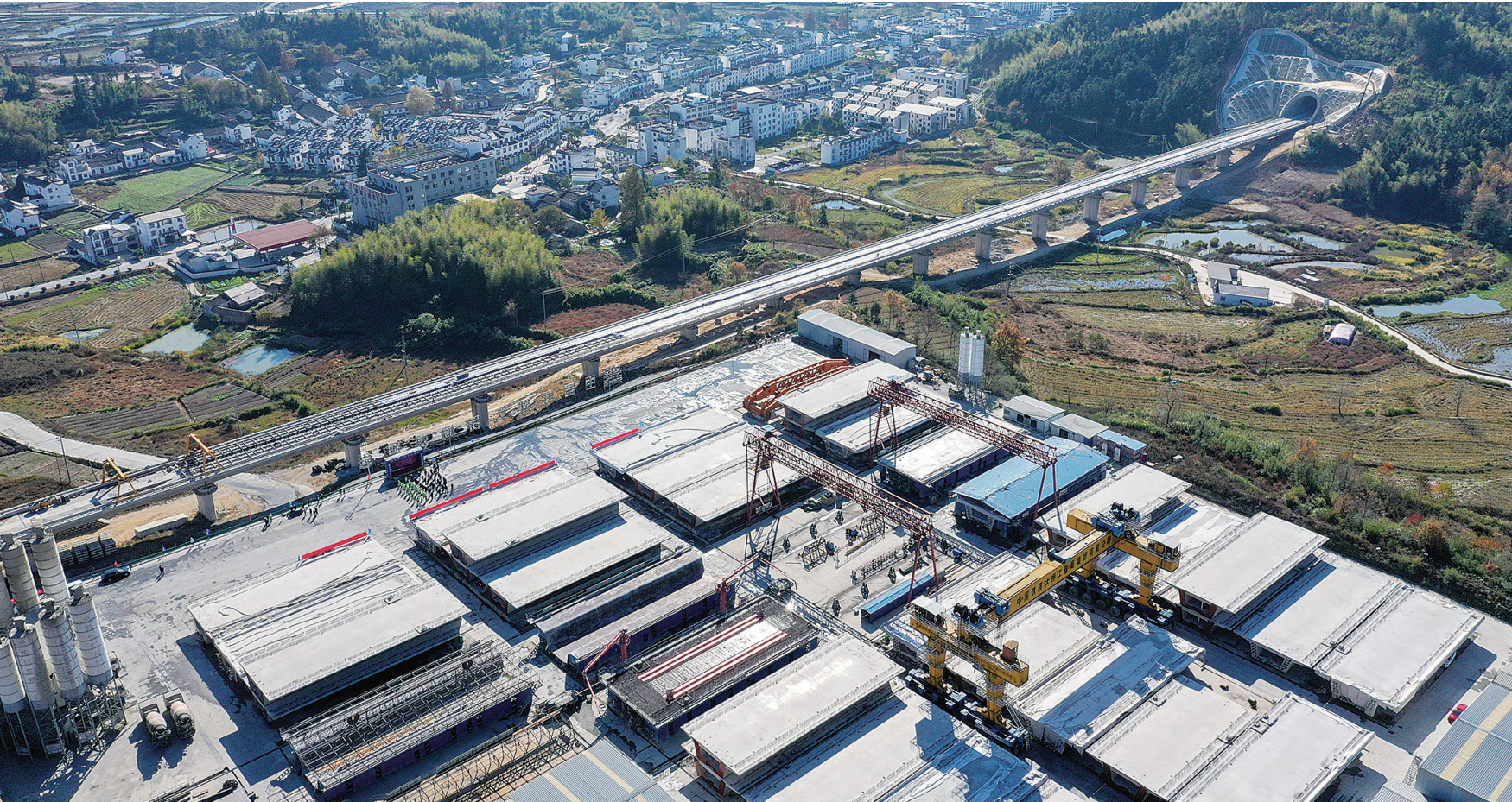
池黄铁路黄山制梁场完成全部箱梁预制 11月7日，中国铁建大桥局池黄铁路黄山制梁场施工人员在最后一榀箱梁浇筑现场施工（无人机照片）。当日，随着第302榀箱梁顺利浇筑完成，中国铁建大桥局池黄铁路黄山制梁场完成全部箱梁的预制任务，为后续工程施工提供保障。池黄铁路全长约125公里，设计时速350公里，是武（汉）杭（州）快速铁路通道的重要组成部分。 新华社发（施亚磊摄）
