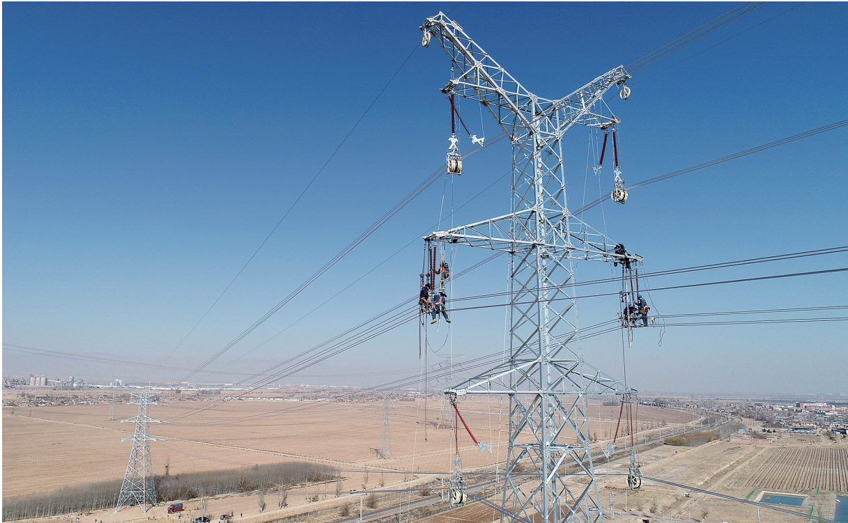
银川：双跨输变电工程 铺就电力高速路
