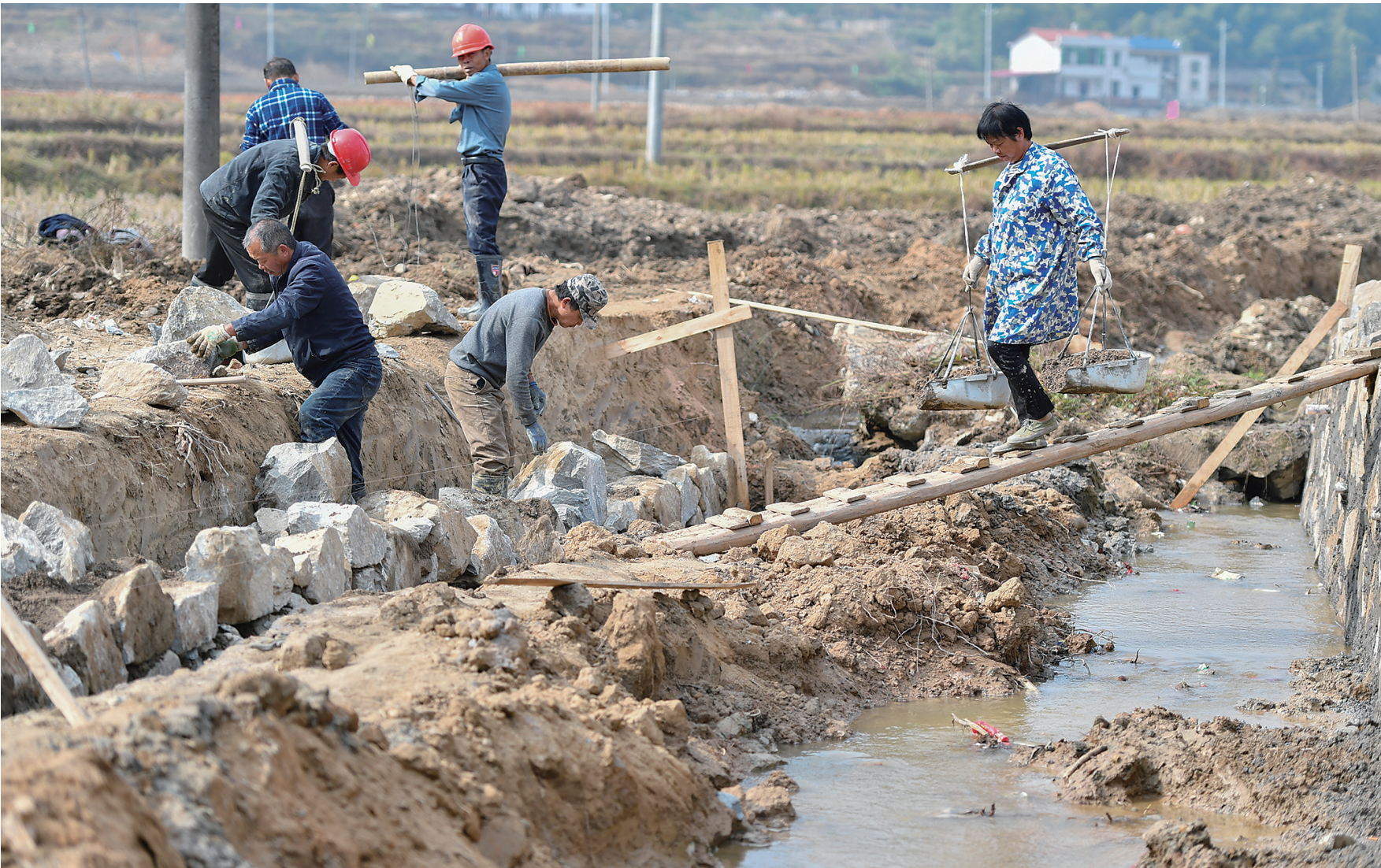
11月17日，在湘潭市湘乡市梅桥镇梅桥村，工人进行水渠改造作业。 近期，湖南省湘潭市湘乡市利用冬季农闲时期，加紧推进高标准农田建设，通过平整土地、改造水渠、修建蓄水池和机耕道等，改善农田灌溉及耕种条件，为来年粮食增产、农民增收打好基础。 新华社记者 陈泽国摄
