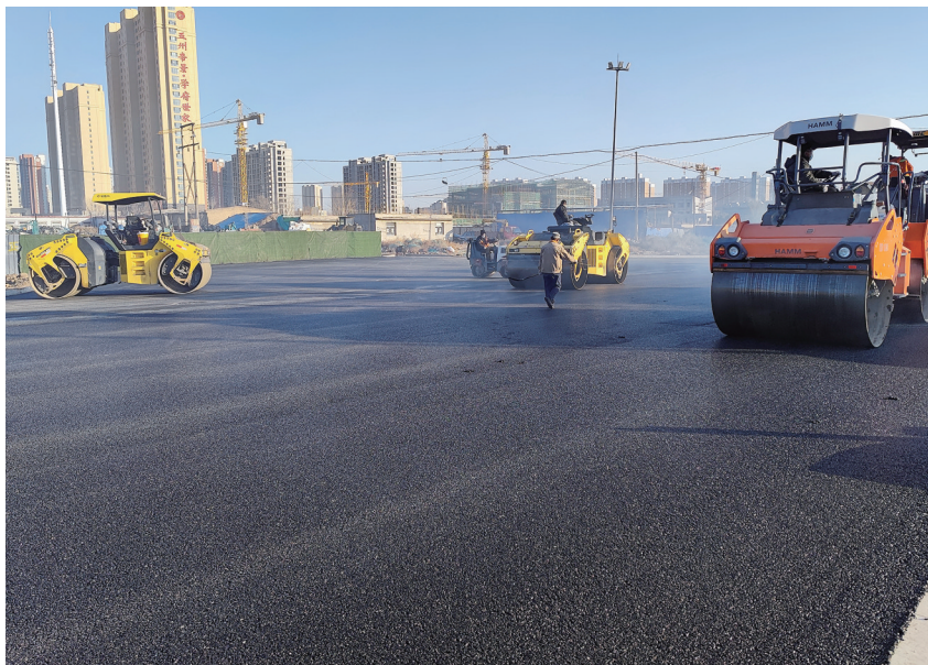
图为北环路道路工程面层沥青铺设施工现场。 本报记者 张世敬摄
