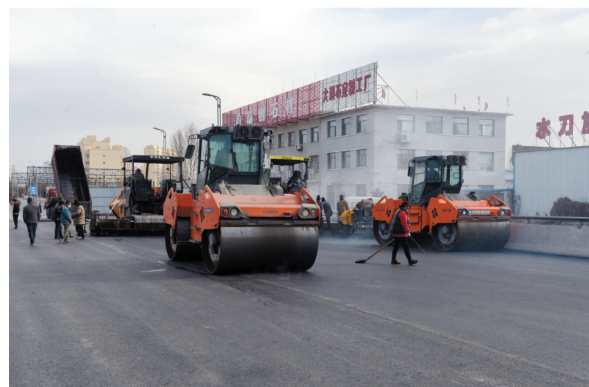
图为糖厂立交桥面层沥青铺设施工现场。
