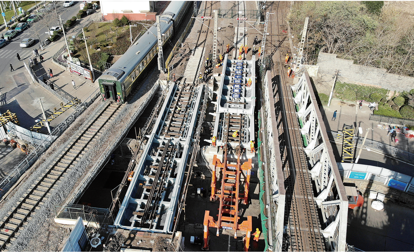
胶济铁路:百岁钢桥“脱胎换骨”展新颜 中铁十四局建设者在对青岛海岸路钢梁桥进行最后一孔钢梁更换作业(12月5日摄,无人机照片)。 当日,有着百年历史的胶济铁路山东青岛海岸路段钢梁桥换梁顺利完成。据了解,该桥始建于1901年,因年代久远,梁体锈蚀、承载力衰减,存在一定安全隐患。铁路建设者通过仿真模拟、数据验算等技术手段,创新采用一体式换梁施工工艺,确保了旧梁拆除、新梁更换施工准确,为后续该路列车安全通行提供了保障。
