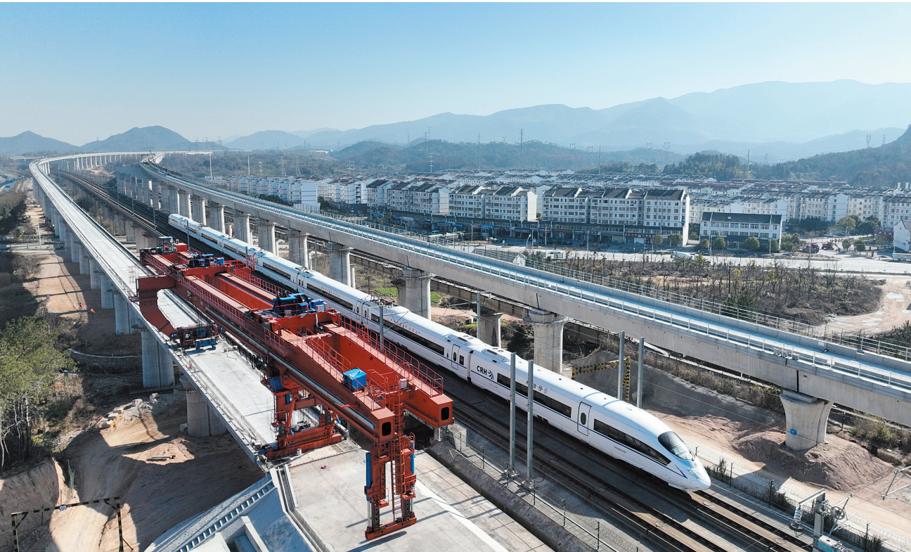
12月23日，在安徽池州，中铁十一局池黄铁路站前一标最后一榀箱梁架设完成（无人机照片）。当日，在安徽省池州市，中铁十一局池（州）黄（山）铁路站前一标完成最后一榀箱梁架设任务，标志着该标段转入线上施工阶段。池黄铁路全长约125公里，设计时速350公里，是武（汉）杭（州）快速铁路通道的重要组成部分。 新华社发（成忠摄）
