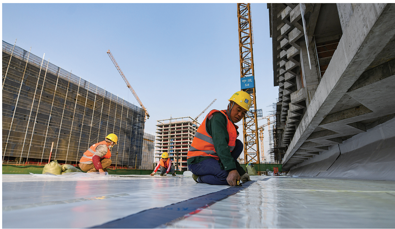
2月2日，工人在成都芯谷产业功能区配套设施建设工程施工现场，工人正加紧施工，全力推进项目建设进度。新春伊始，在由中建三局承建的成都芯谷产业功能区配套设施建设工程工地上，工人正加紧施工，全力推进项目建设进度。据了解，成都芯谷产业功能区配套项目建成后，将为成都市双流区发展提供产业服务、文化体验、政务保障等多种核心功能，为成都市电子信息产业建圈强链提供重要支撑。
