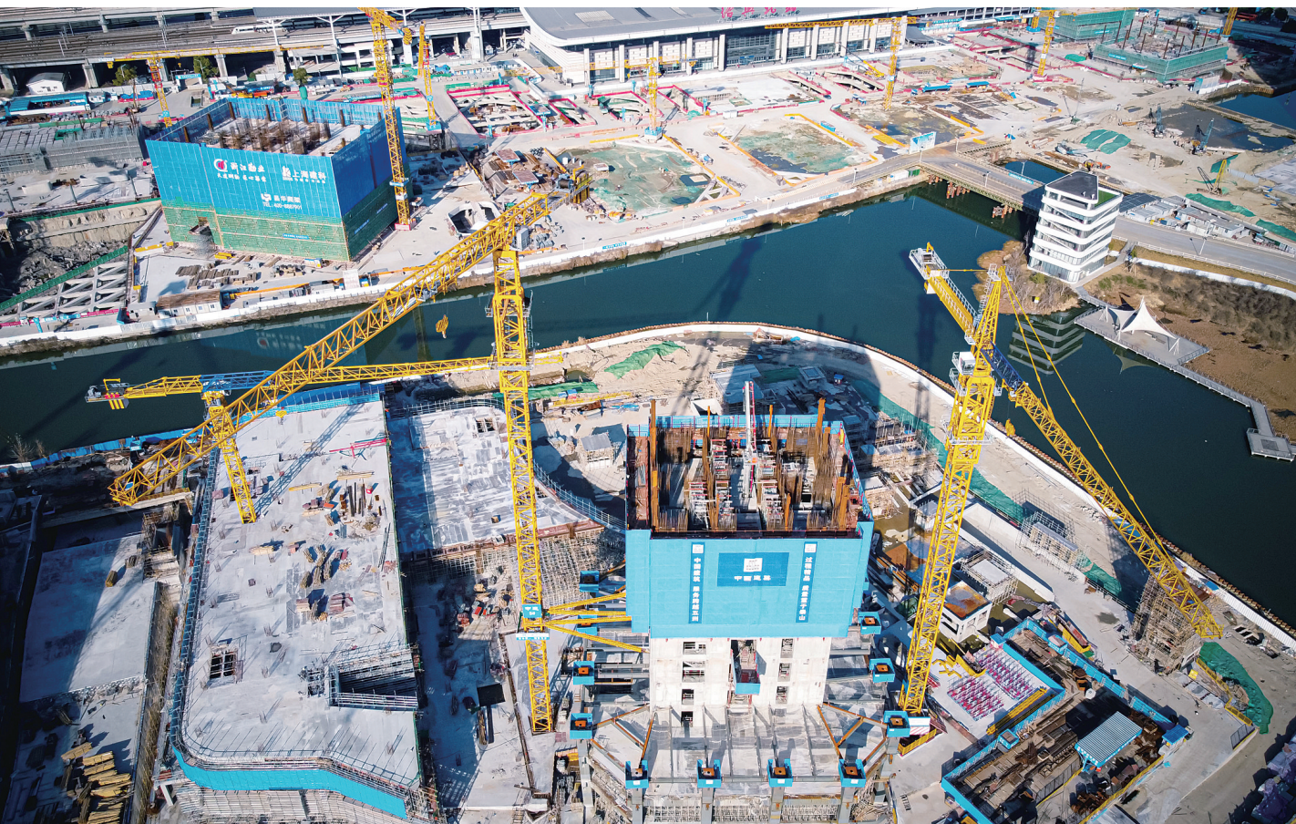
绍兴北站TOD综合交通枢纽工程建设现场（1月31日摄，无人机照片）。由中建三局承建的这项工程为浙江省重点工程，建成后将是集商务办公、科创研发、星级酒店等多功能于一体的智慧城市交通综合体（无人机照片）。新华社记者 江汉摄
