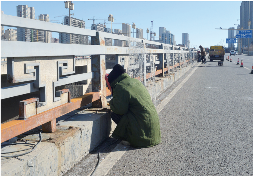
为保障市民出行安全、提升城市功能品质，连日来，市城市管理局桥涵设施服务所相继对北都桥、兴云桥等的安全防撞护栏进行维修保养作业，消除桥梁病害和安全隐患。图为2月20日，施工人员进行换修兴云桥损坏的护栏。 本报记者 戎禹仁摄
