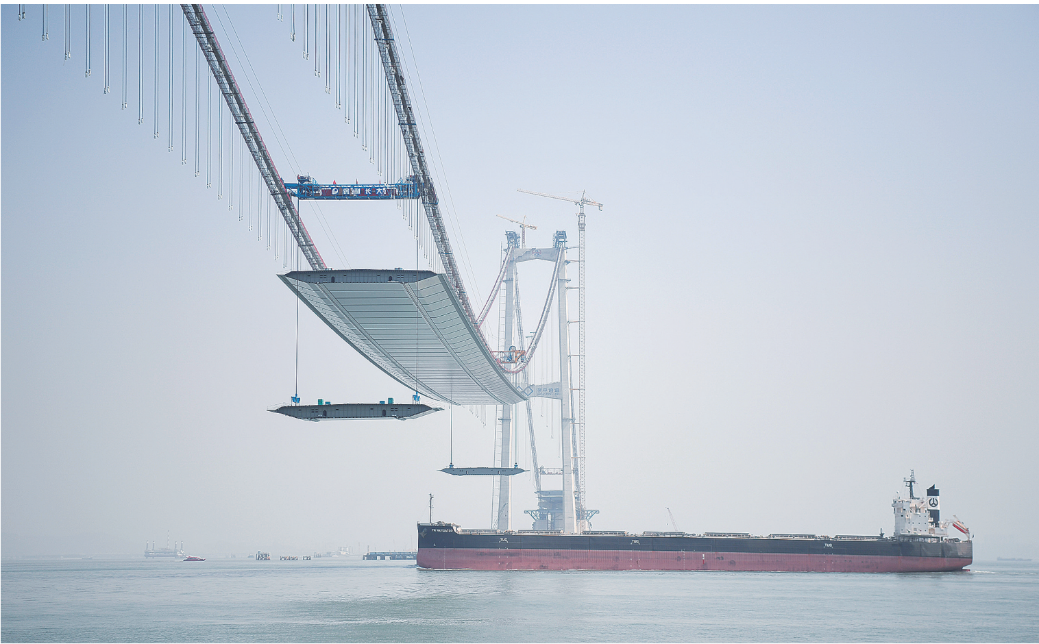
2月22日，货轮通过正在吊装钢箱梁的深中通道伶仃洋大桥。目前，深中通道伶仃洋大桥正有序推进钢箱梁吊装施工。伶仃洋大桥是深中通道的重要组成部分，主跨1666米，是世界上最大跨径的海上钢箱梁悬索桥。 新华社记者 邓华摄
