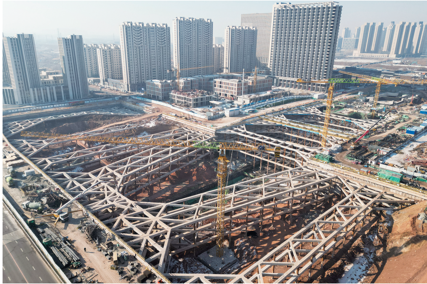
2月23日拍摄的长春市城市轨道交通6号线03标段三工区车庆路施工现场(无人机照片)。立春以来,长春市加快轨道交通项目建设,全市8个在建项目同步推进。目前,长春市轨道交通项目在建里程128公里。本期建设完成后,将形成“十字交叉、环状包围”的轨道交通网络,与机场、高速铁路、城际铁路无缝对接,运营总里程数将达235公里。新华社记者 许畅 摄
