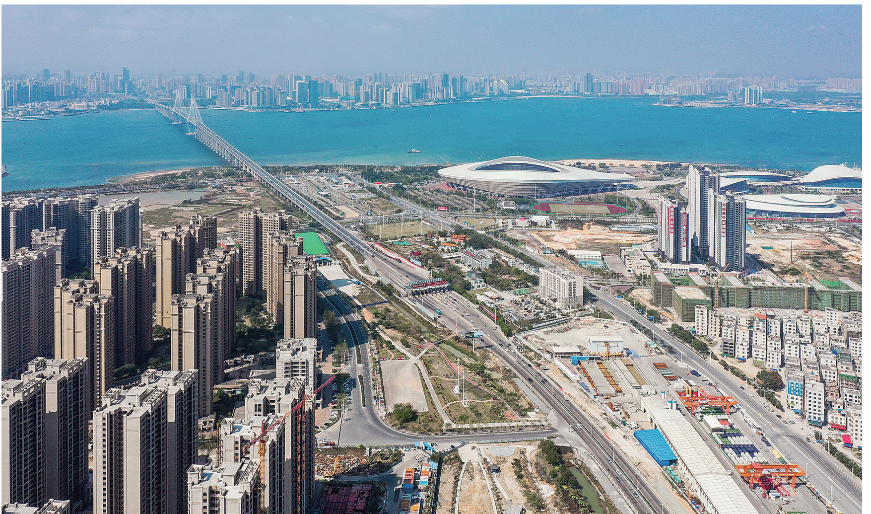
2月28日,广湛铁路湛江湾海底隧道盾构区间“过海穿城”(无人机照片)。近日,中铁十四局承建的广湛铁路全线控制性工程——湛江湾海底隧道盾构施工由“穿海模式”转为“穿城模式”,并在穿城过程中顺利与湛江湾大桥海滨路立交桥桩基以不足1米的间距“擦肩而过”。湛江湾海底隧道盾构段全长7551米,开挖直径14.33米,目前已累计掘进4546米。
