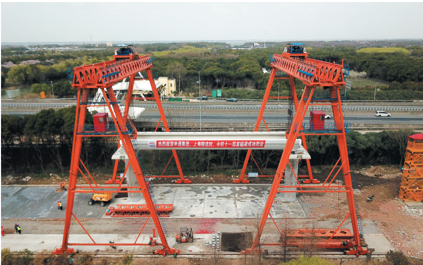
3月12日拍摄的上海轨道交通17号线西延段工程施工现场（无人机照片）。当日，在上海轨道交通17号线西延段工程施工现场，一片长30米，宽5.5米，高2米，重200吨的预制U梁从起重机上平稳落架就位，标志着17号线西延段开始架梁施工。17号线西延段位于上海市青浦区，从既有东方绿舟站延伸至西岑站，全长6.6公里。
