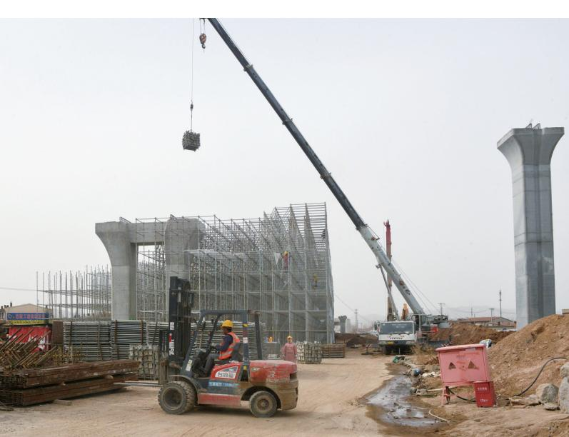
3月24日,在同煤快速干线西段施工现场,吊车、运输车等大型机械正在有序运转,工人们忙碌地作业。市住建局现场负责人向记者介绍,2月中旬施工人员陆续赶到工地,于3月1日全面复工,目前施工现场共有200余人。同煤快速干线西段包含大同市开源街快速化改造工程(落地段)和大同市黄花产业园区配套基础设施项目。目前,开源街快速化改造工程的工人们正忙着搭建盘扣支架、切割钢筋,为下一步箱梁安装做准备;黄花产业园区配套基础设施项目的工人们正在进行桥梁桩基、承台、墩身和桥梁混凝土箱梁的施工。
