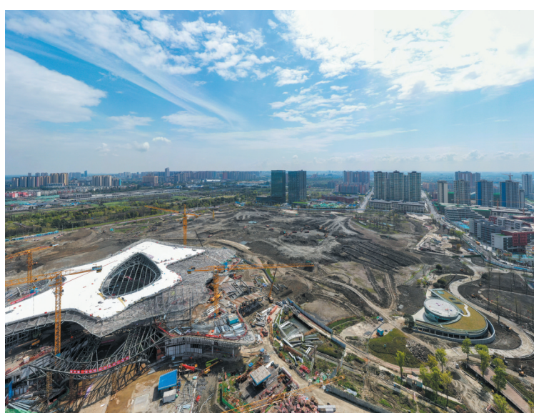
这是3月27日在四川成都拍摄的世界科幻公园建设现场（无人机照片）。目前，第81届世界科幻大会配套工程世界科幻公园在四川成都加紧建设，各道工序陆续穿插进行，整体工程预计将于今年8月底竣工。新华社记者 王曦 摄
