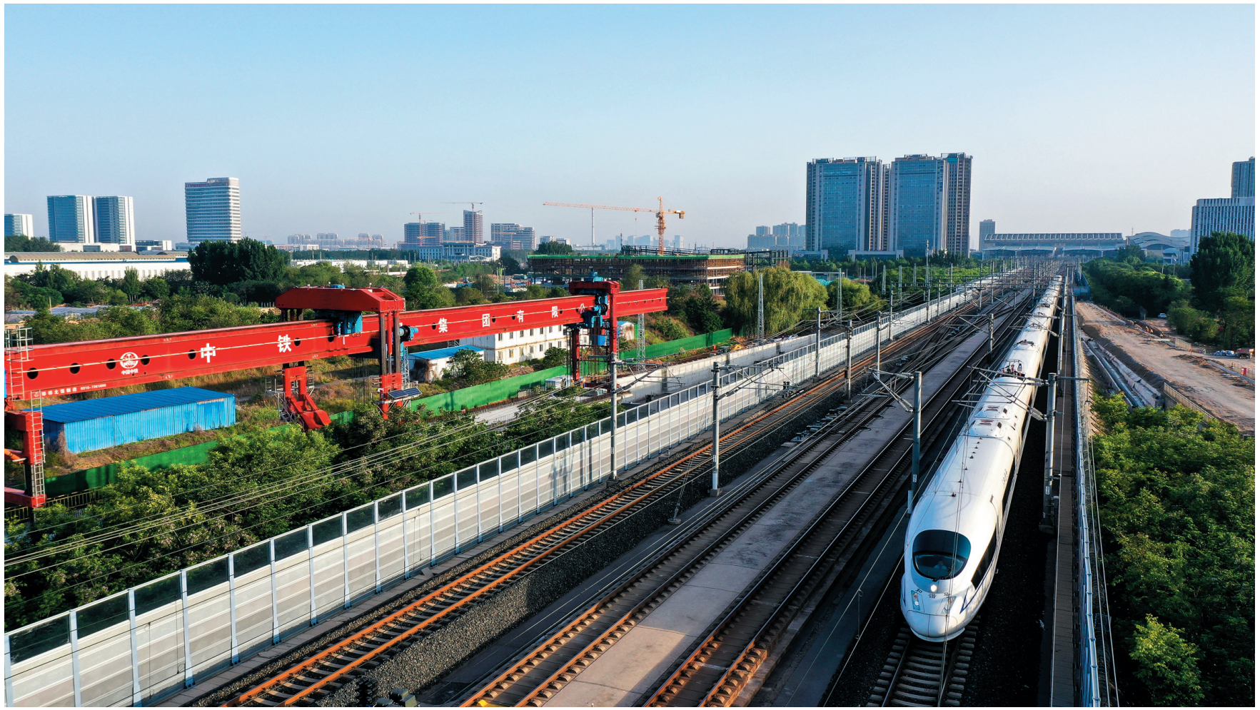
济郑高铁山东段完成全线箱梁架设
