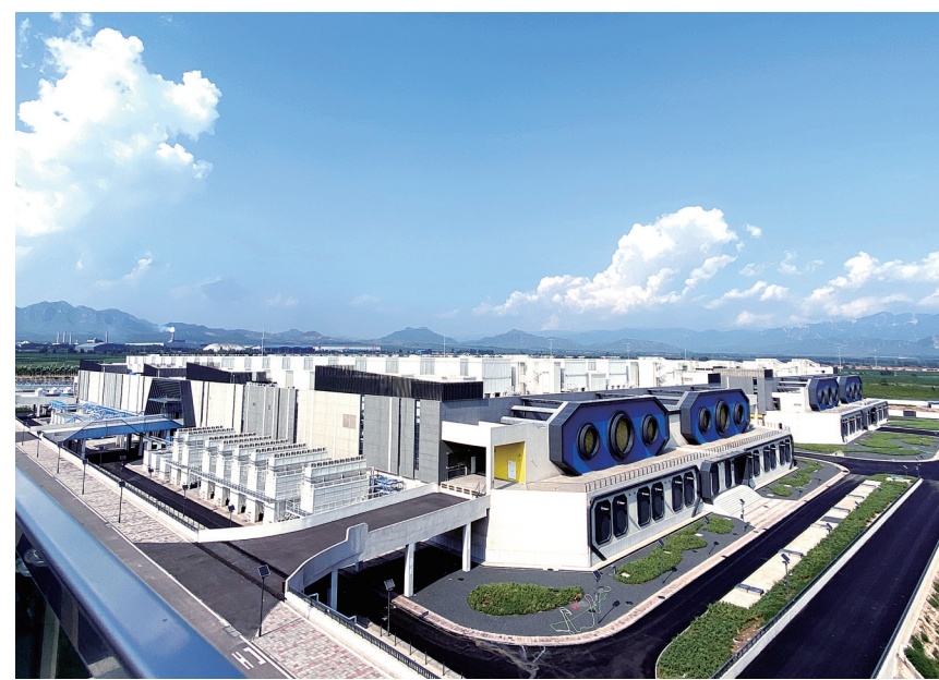
图为位于灵丘县的秦淮数据环首都·太行山能源信息技术产业基地。
