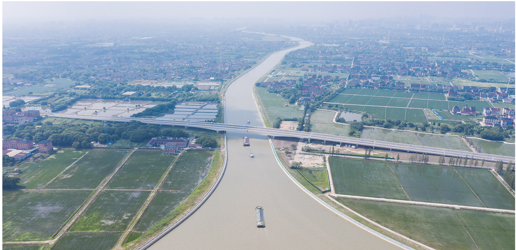
京杭运河杭州段二通道建成通航
