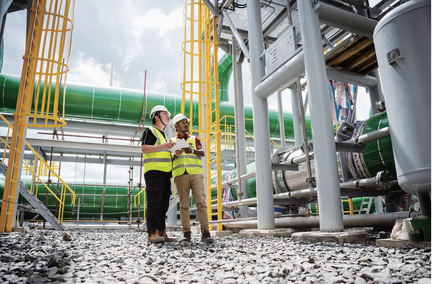
5月26日，施工人员在位于肯尼亚纳库鲁市的索西安地地热电站项目建设现场检查发电设施。 近年来，肯尼亚经济增速在非洲国家中名列前茅，电力需求也随之显著攀升。然而，电力供应短缺、电价过高成为制约其经济发展的主要瓶颈之一。 为弥补电力缺口和控制发电成本，肯尼亚政府计划加速建设地热发电设施。在此背景下，中国企业积极响应“一带一路”倡议，凭借自身技术与成本优势，助力肯尼亚加快推进能源转型。其中的索西安地地热电站是非洲首个从设计、产品生产到建设、调试完全由中国企业独立完成的发电站。“100%中国技术”让这个地热发电站备受各方关注。 新华社发
