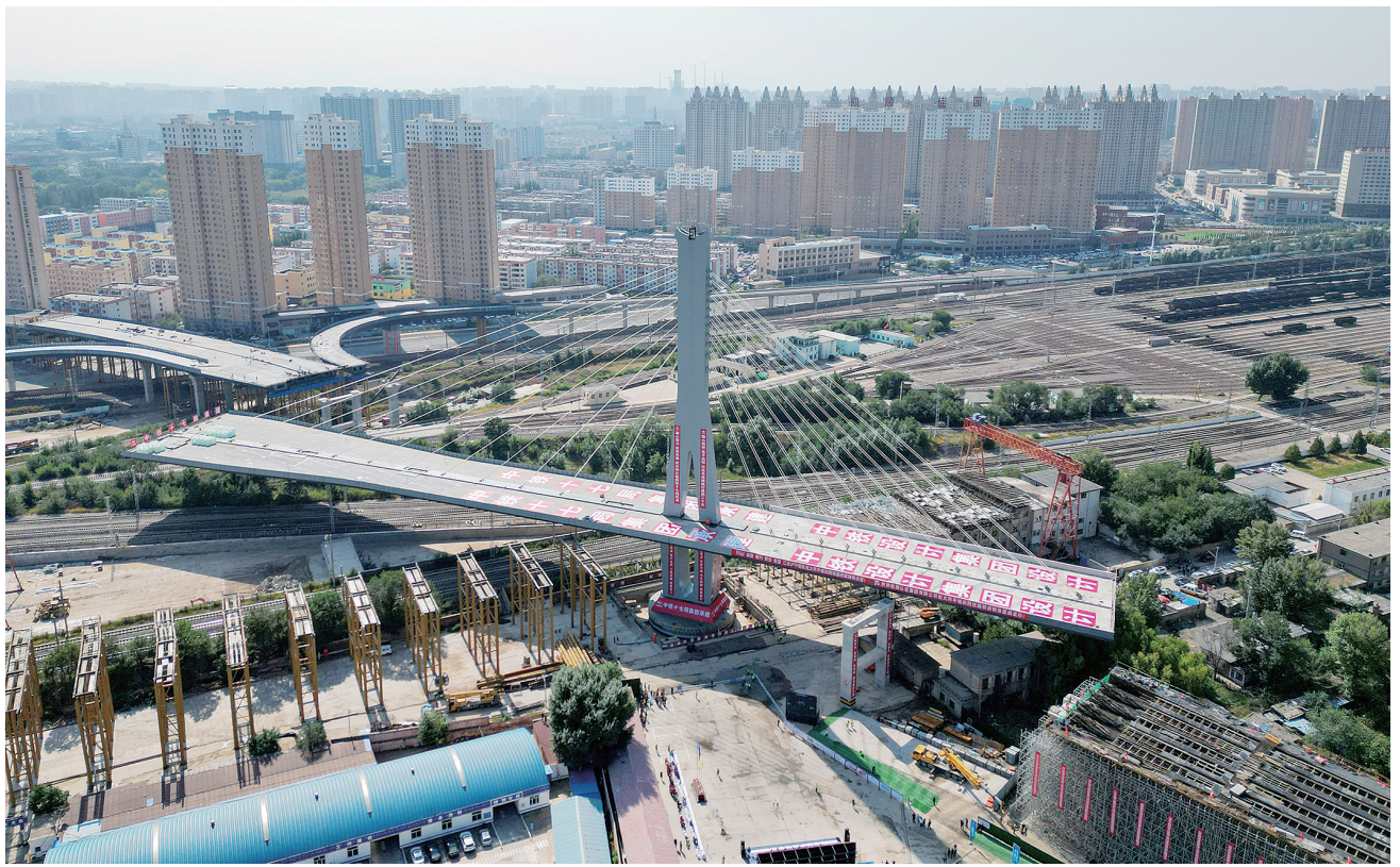
图为平城街西延跨铁路桥转体施工现场。
