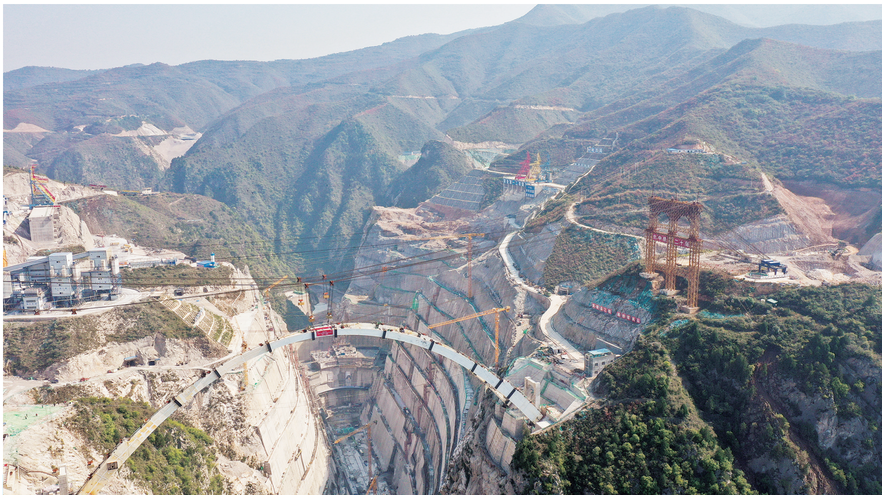
陕西东庄水利枢纽泾河大桥主拱合龙
