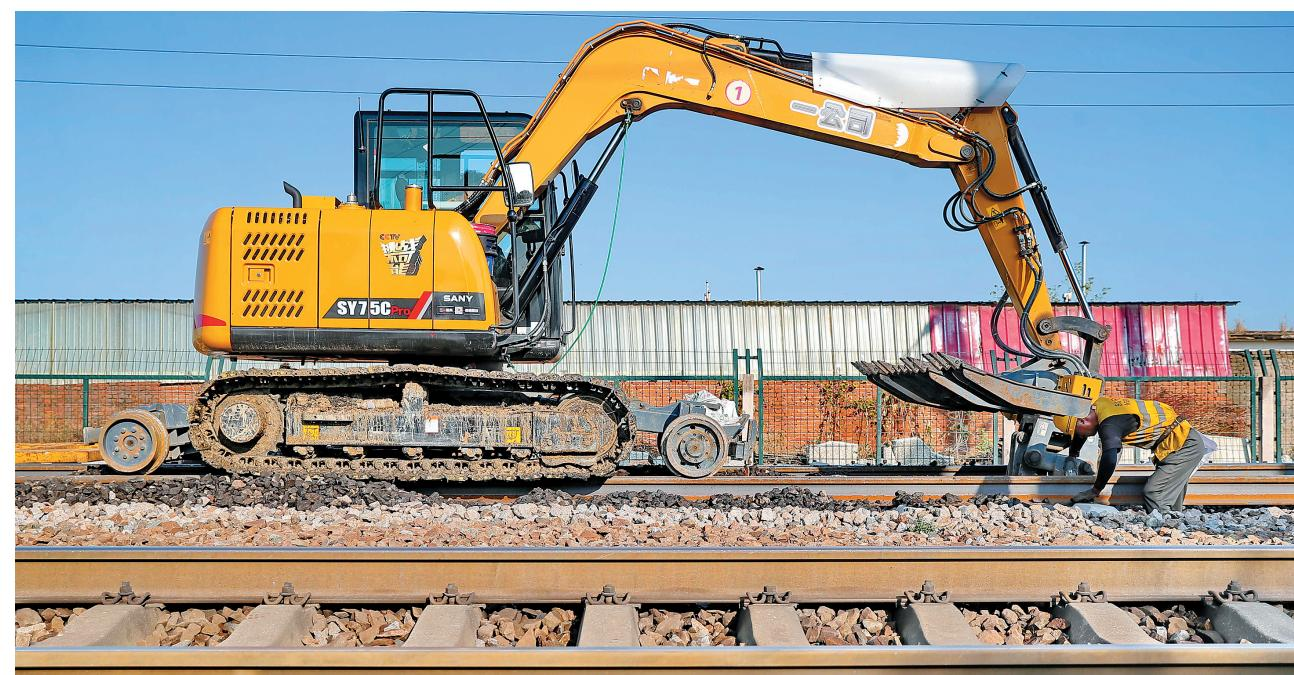
10月14日，中国铁路太原局集团有限公司秦皇岛工务段职工在大秦铁路秦皇岛段进行成段更换枕木施工作业。10月4日开始，我国“西煤东运”主通道大秦铁路开展秋季集中修施工，此次集中修为期20天。连日来，铁路职工对全线设施设备进行全面方位、立体式更新维护，消除长期高负荷运转后产生的设备病害，为今冬明春电煤运输提供坚实保障。新华社发(曹建雄摄)
