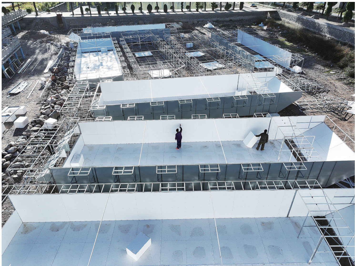
为加快现代渔业产业布局，培育壮大多种渔业业态，推动渔业产业绿色健康高效发展，我市出台《大同市推动渔业产业发展实施意见》和渔业产业发展十条政策，对渔业产业发展给予政策倾斜、资金奖励，调动和激发了水产养殖企业扩大规模、做好做优渔业产业的激情和干劲，一大批渔业项目正在热火朝天建设中。灵丘县下北泉村借助山水资源优势，加大水产养殖规模，新建工程化循环水养殖项目，预计建成后每年水产品可新增15万公斤，为“大同水产”品牌再添新军。图为10月14日该村养殖区内正在建设中的养殖槽。 本报记者 张占兵摄
