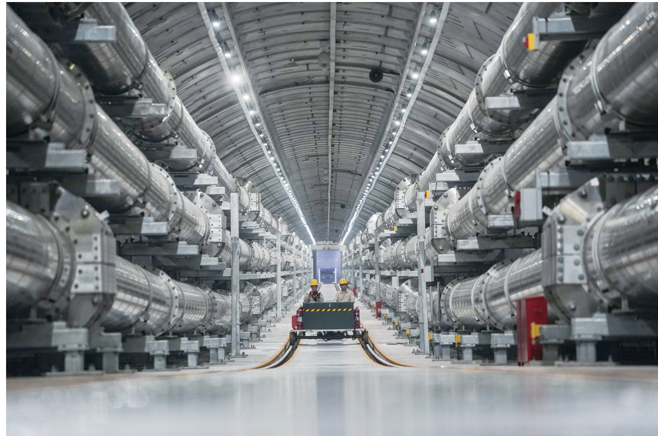
10月19日，国网江苏电力工作人员在苏通GIL管廊开展例行巡检。近日，华东特高压交流环网过江的关键节点——苏通GIL管廊跨江送电超1000亿千瓦时。苏通GIL管廊工程起于长江南岸苏州，止于北岸南通，于2019年9月正式投运。该工程采用“紧凑型特高压GIL+大直径长距离水下隧道”穿越长江，江底“埋线”长达5.5公里，总投资47.63亿元。新华社记者 李春鹏摄
