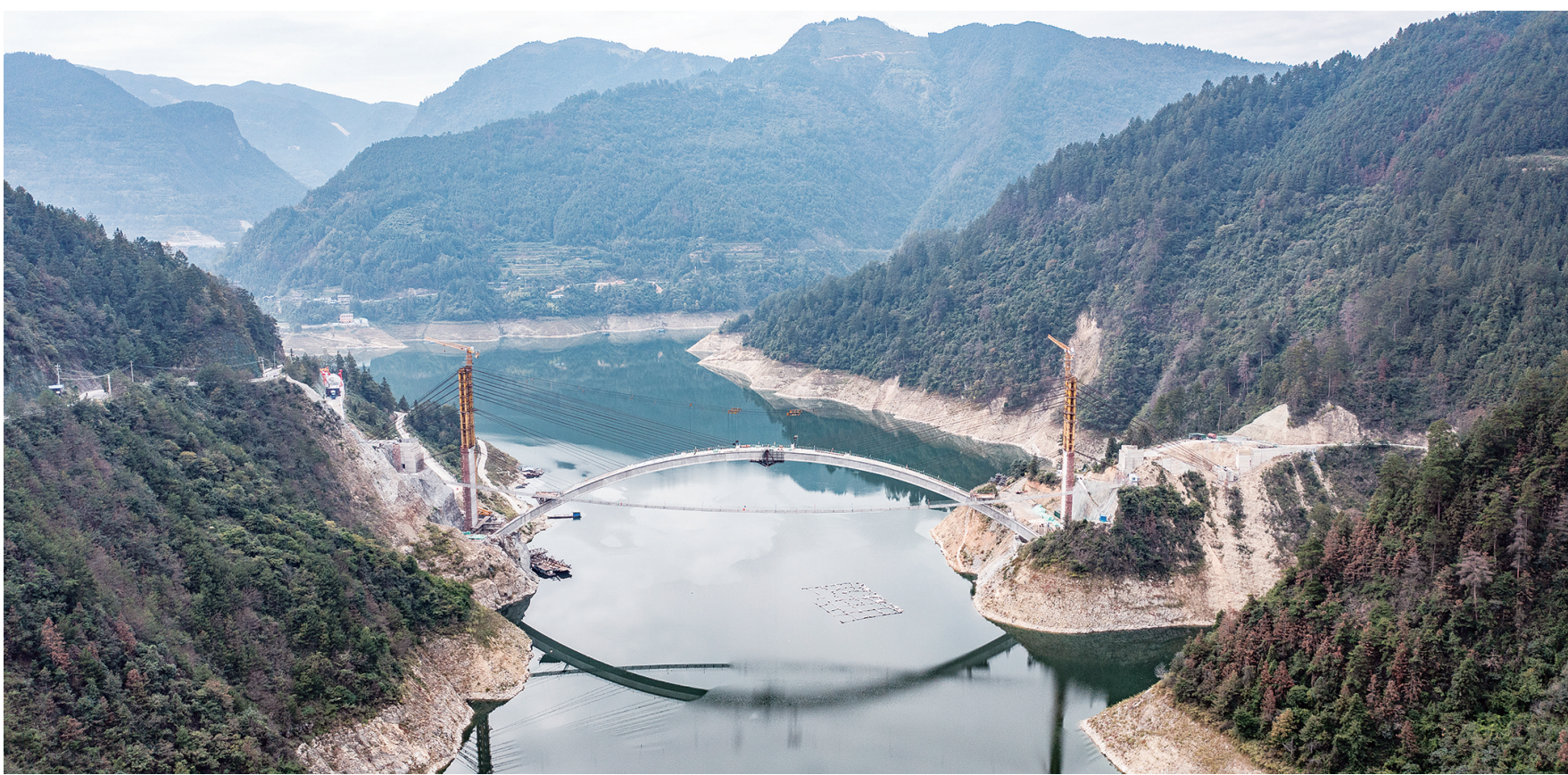
10月23日，贵州路桥集团承建的锡绣大桥主拱圈顺利合龙（无人机照片）。当日，由贵州路桥集团承建的锡绣大桥主拱圈顺利合龙。锡绣大桥位于贵州省黔东南苗族侗族自治州剑河县境内，是附近乡镇群众横跨清水江三板渡库区的快捷通道，桥梁建成后极大缩短两岸往来的通行时间。新华社记者 陶亮摄
