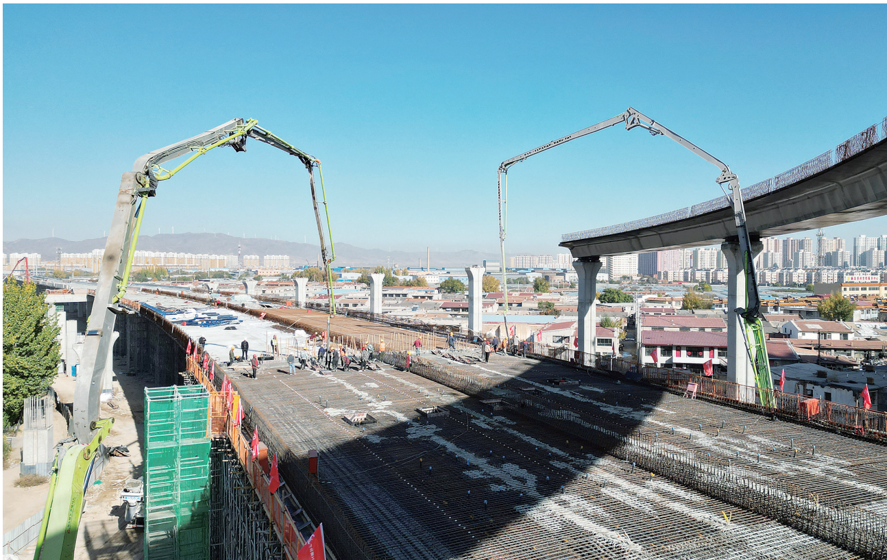
图为同煤快线西段开源街快速化改造桥梁施工现场。
