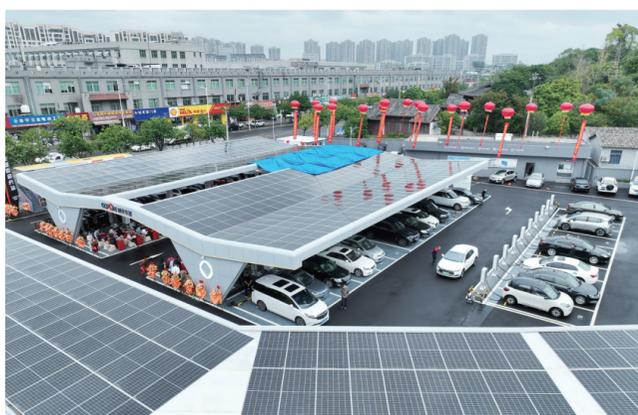
10月27日拍摄的福州市仓山区齐安路的齐安智检超充站（无人机照片）。当日，一座集光伏、储能系统、电动汽车充放电和动力电池检测功能于一体的“光储充检”智能超充站在福建省福州市仓山区齐安路投用。
