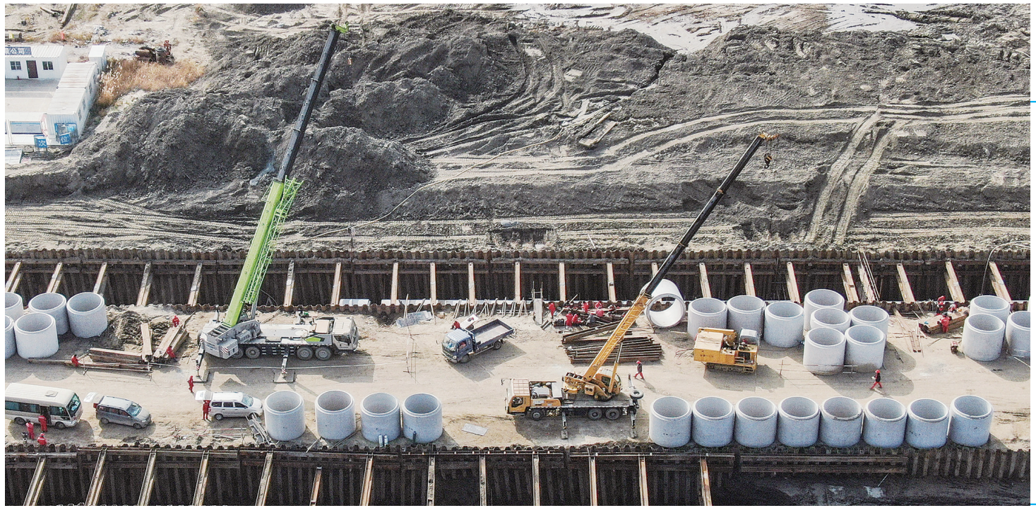
11月1日拍摄的华锦阿美精细化工及原料工程项目施工现场（无人机照片）。国家支持东北振兴的重点项目、沙特阿美公司与中国企业共同投资837亿元的华锦阿美精细化工及原料工程项目正在辽宁盘锦稳步推进。该项目位于辽宁省盘锦市辽滨经开区，于2023年3月全面开工，建成后将成为一座世界级石化和精细化工基地。新华社记者 潘昱龙摄
