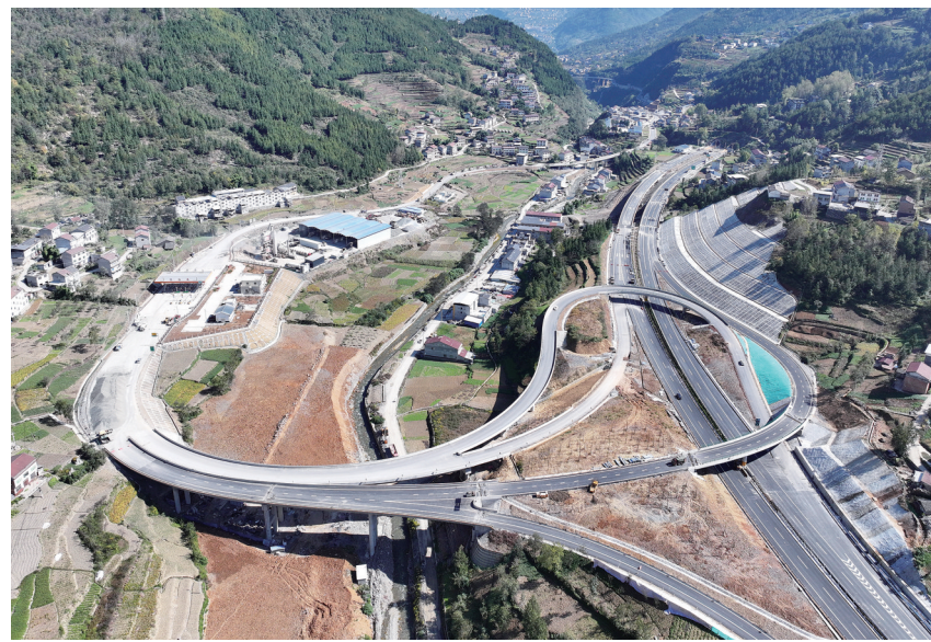
巫镇高速公路中坝互通施工现场(11月1日报，无人机照片)。
