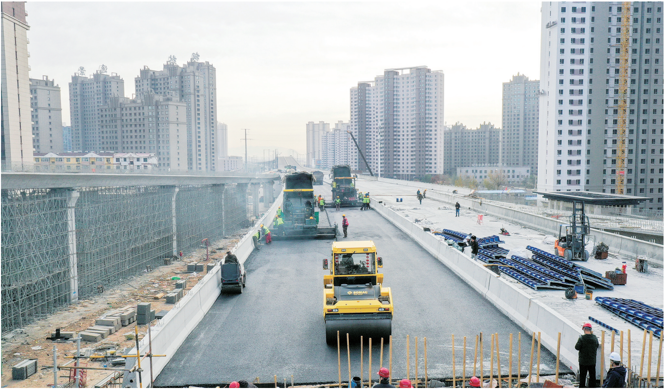
图为施工人员正在对东半幅桥面进行沥青摊铺作业。
