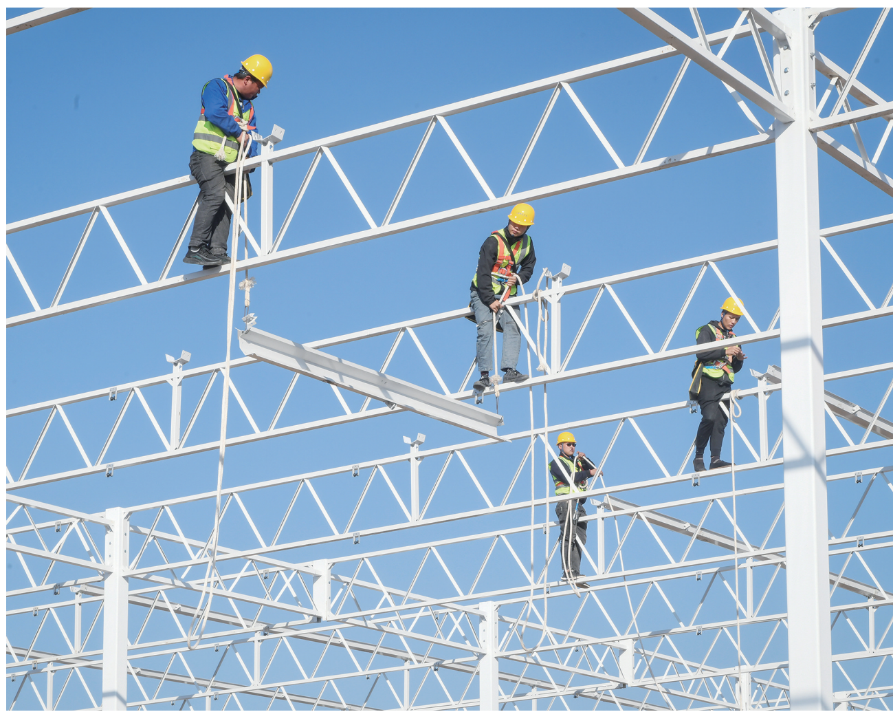
11月9日，天镇县现代农业产业示范园内，工人们正在建设玻璃温室大棚。天镇县现代农业产业示范园是从山东寿光引进的战略合作项目，将借助寿光蔬菜产业技术、渠道、运营体系，引领带动天镇设施蔬菜产业全面提档升级，大力发展“订单式”设施蔬菜产业，引领带动天镇农业持续增效、更多农民增收。本报记者 张燕伟摄
