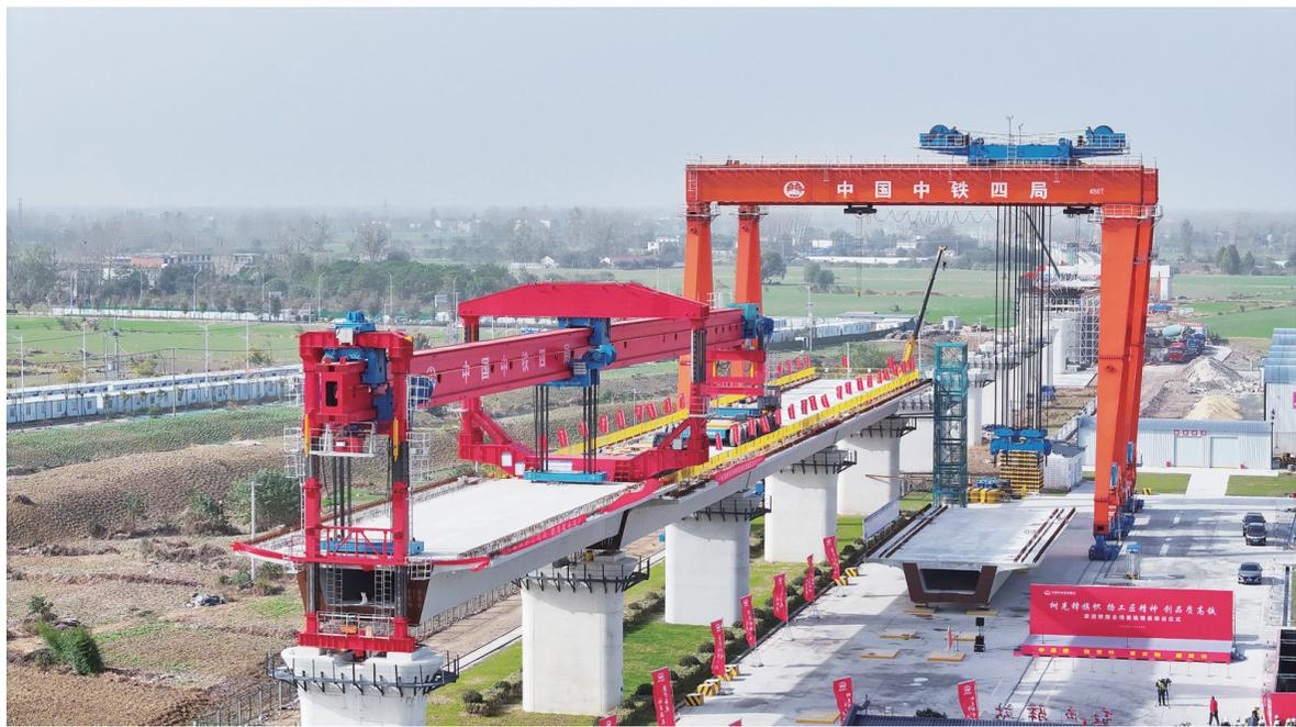
这是中铁四局阜淮铁路全线首榀箱梁架设现场(11月16日，无人机照片)。
