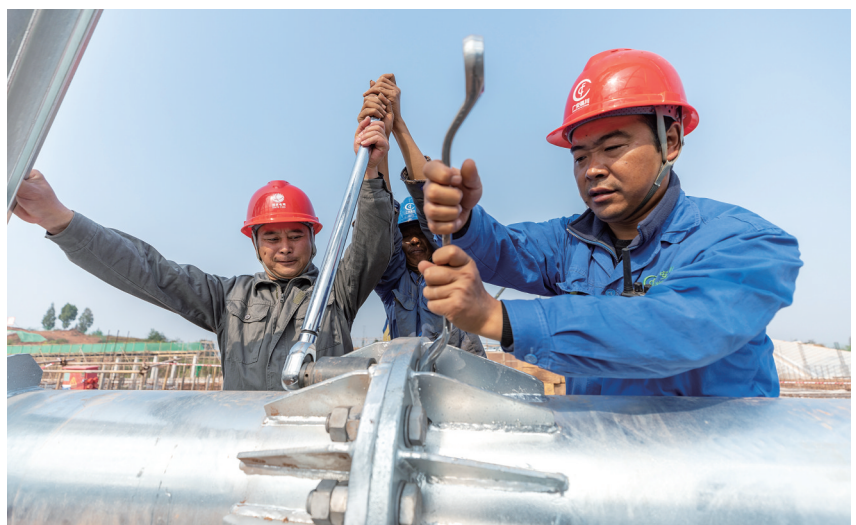
11月28日,在位于重庆市铜梁区少云镇的铜梁1000千伏变电站施工现场,国网重庆送变电公司施工人员在吊装前对构架梁进行检查。
