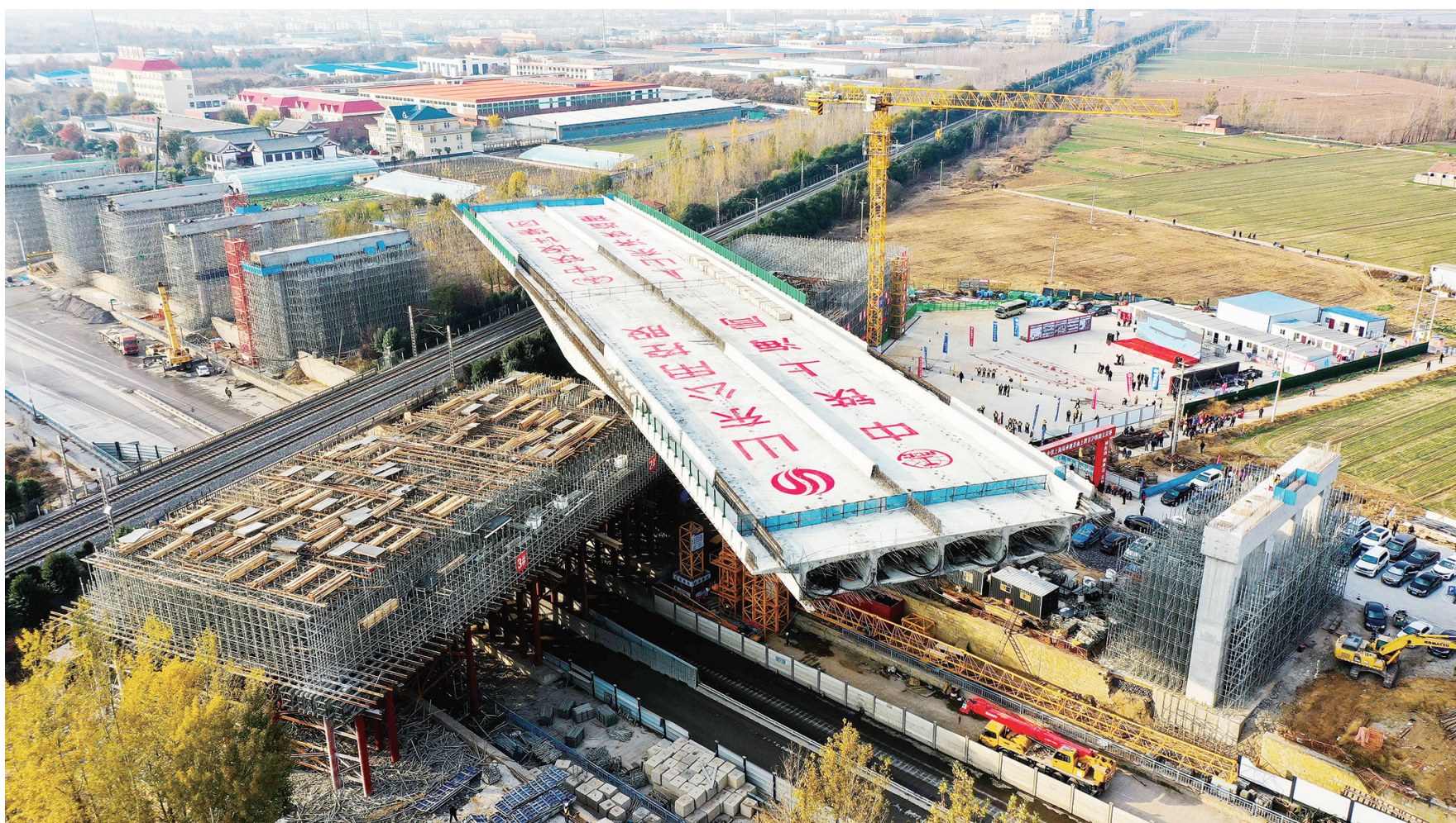
济曲快速路上跨京沪铁路立交桥连续梁转体成功
