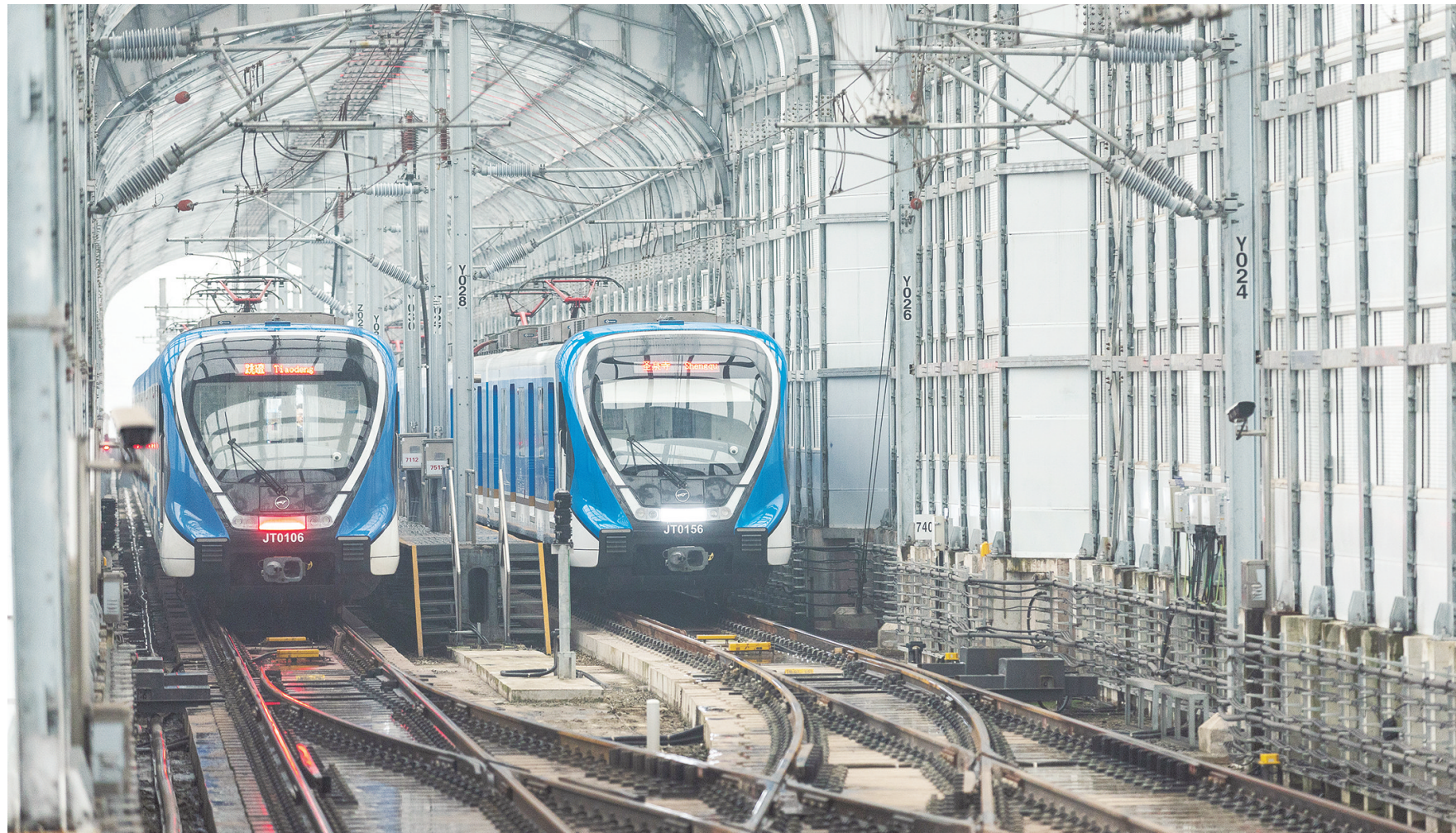
11月30日,贯通列车在江跳线圣泉寺站等候发车。当日,重庆城市轨道交通江跳线与重庆轨道交通5号线正式贯通载客运营,列车从江跳线圣泉寺站运行至5号线石桥铺站,乘客乘坐贯通列车即可实现跨线运行、零换乘。换乘方式由“人换乘”变为“车换线”,为乘客节省换乘时间的同时,提升乘客出行体验。 新华社记者 黄伟摄
