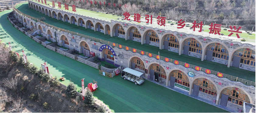
西吉县吉强镇龙王坝村窑洞宾馆(12月1日报,无人机照片)。
