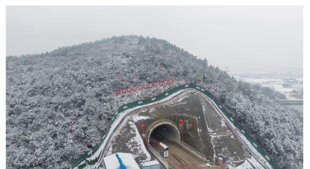
这是巢马城际铁路青山隧道进口(12月19日摄，无人机照片)。当日，由中铁四局承建的巢马城际铁路江北段青山隧道顺利贯通，为后续工程施工奠定基础。全长698米的青山隧道位于安徽省马鞍山市含山县境内，为双线单洞隧道。巢马城际铁路是国家“八纵八横”高铁网沪汉蓉快速通道合肥至上海间的重要组成部分，设计时速350公里。新华社发(刘玉才摄)
