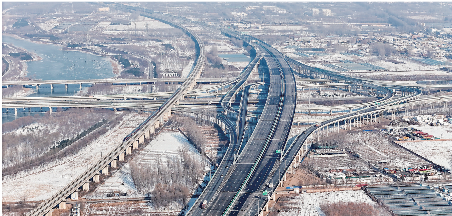
12月28日，车辆行驶在京雄高速北京段上(无人机照片)。当日，京雄高速公路北京五环至六环段顺利贯通。至此，京雄高速全线通车运营。京雄高速是北京连接雄安新区的直通高速公路，主线全长约97公里，其中北京段约27公里、河北段约70公里。从北京西南五环到雄安新区，全线行驶时间约1小时。
