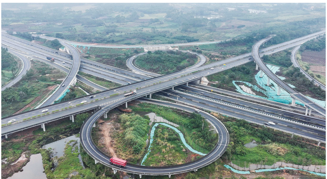
沈海国家高速茂湛段改扩建工程临近收官
