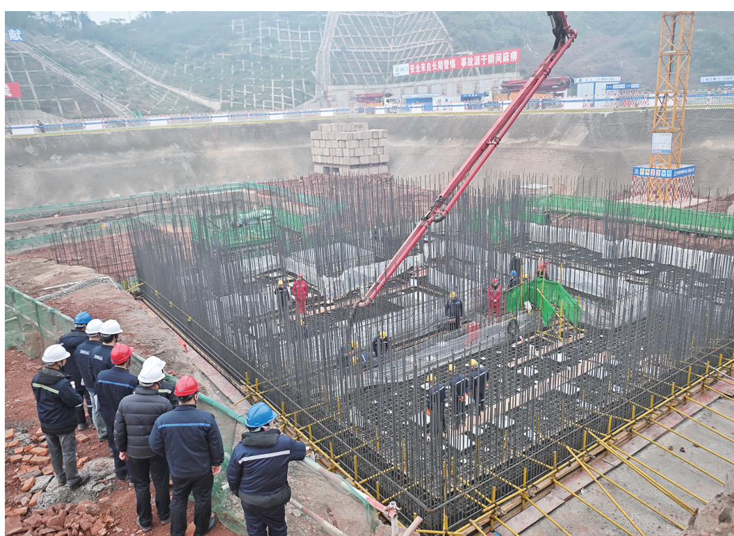
这是1月30日拍摄的医用同位素试验堆施工现场。
