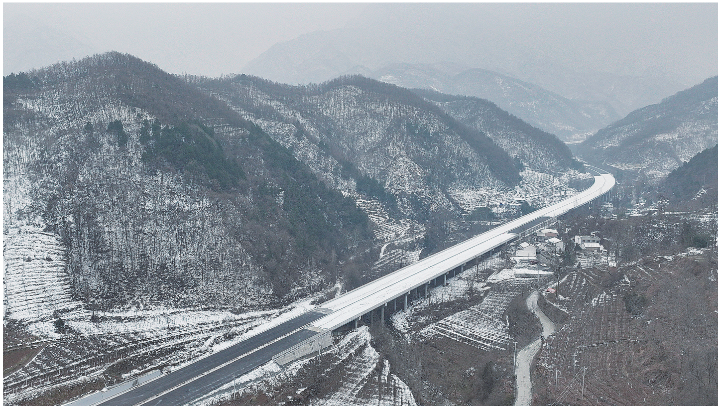
这是二月二十八日拍摄的位于陕西省宝鸡市眉县的眉太高速公路建设现场。春节过后，在位于陕西省宝鸡市的眉县至太白县高速公路建设现场，一片繁忙，参建单位加紧推进施工进度，力争项目早日建成通车。 陕西眉太高速公路跨越秦岭山脉北麓，全长约七十五公里。项目建成后，将进一步加大西秦岭山区与陕北地区的路网联系，对促进秦岭山区经济社会发展具有重要意义。 新华社记者 张博文摄
