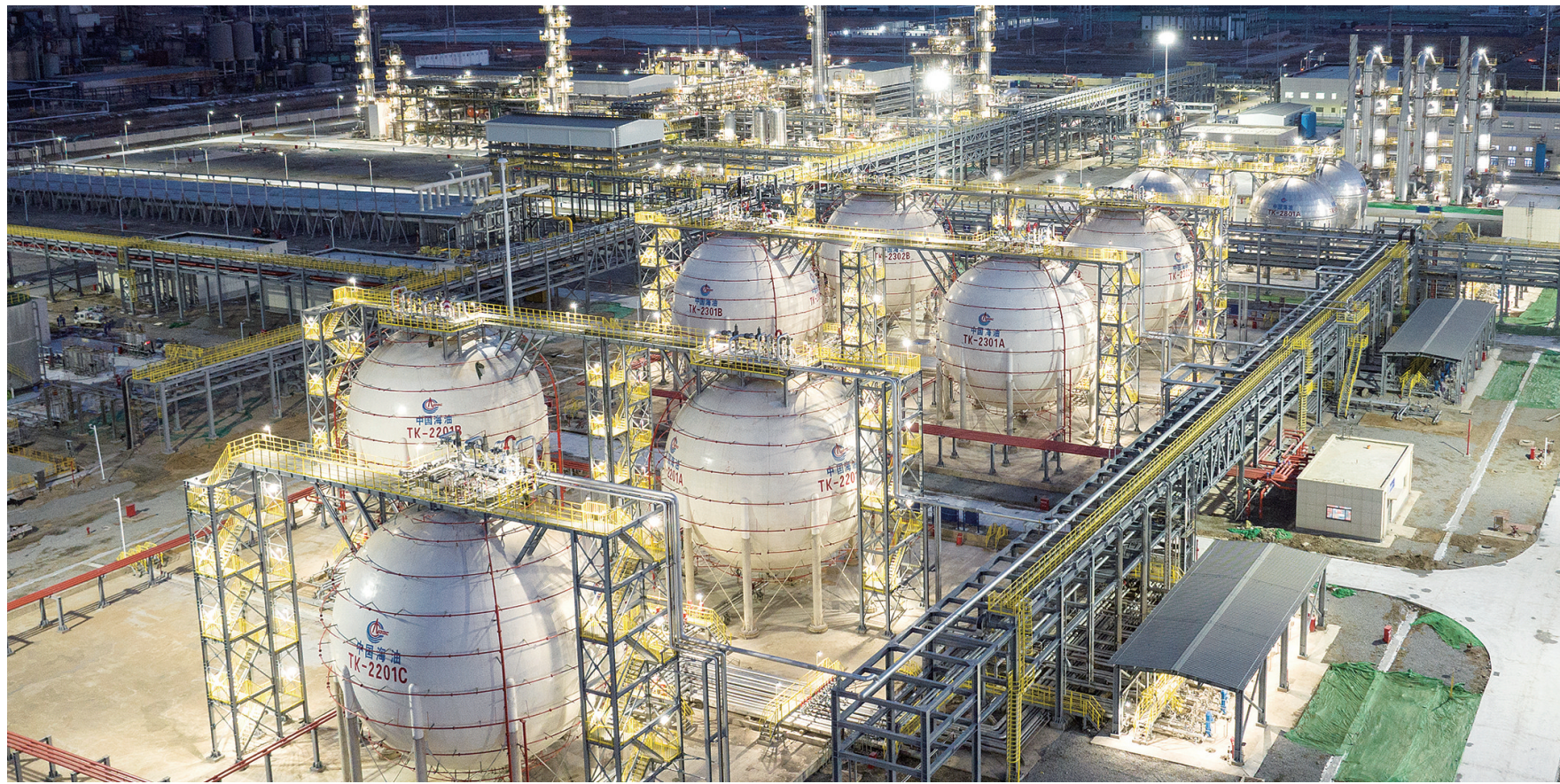
渤海油田最大天然气处理厂正式供气
