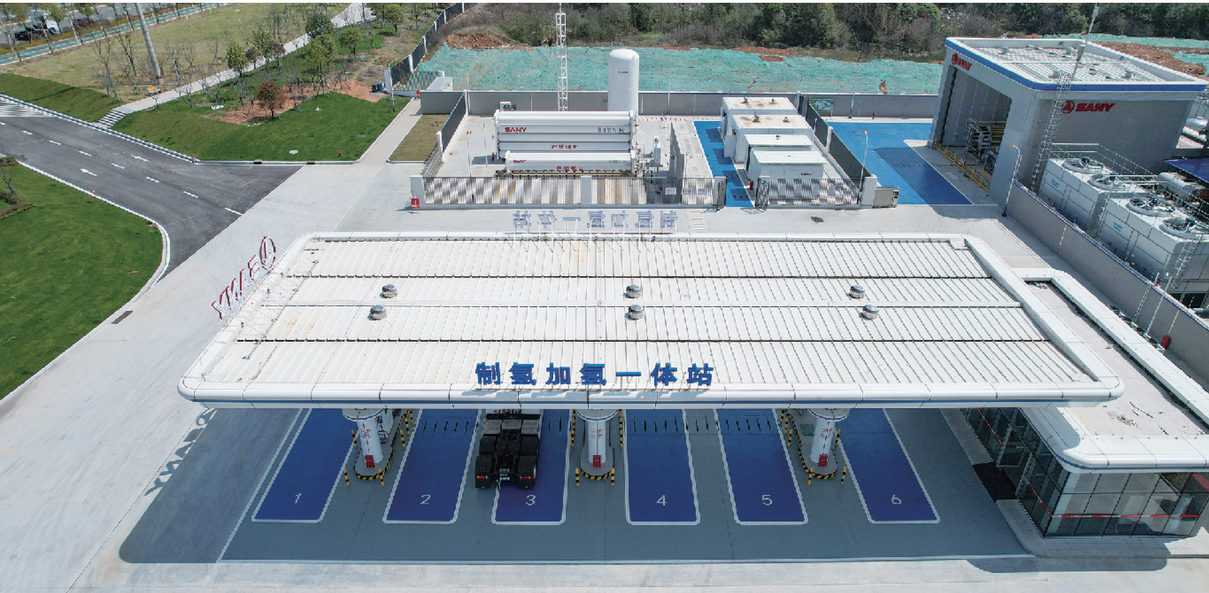
这是3月20日拍摄的长沙经开区的三一绿电制氢加氢一体站（无人机照片）。近日，位于湖南长沙经开区的三一绿电制氢加氢一体站建设完成，具备基础服务能力。该站点是2000公斤级绿电制氢加氢一体站，分为制氢区、增压储存区、加氢区3大功能分区，制氢设备由三一集团自主研发，每日的制氢加氢量不少于2吨，增压储存区总储氢量超过1000公斤，可满足4台氢能车辆同时加注氢气，每天可服务氢能车辆数量超过百台。
