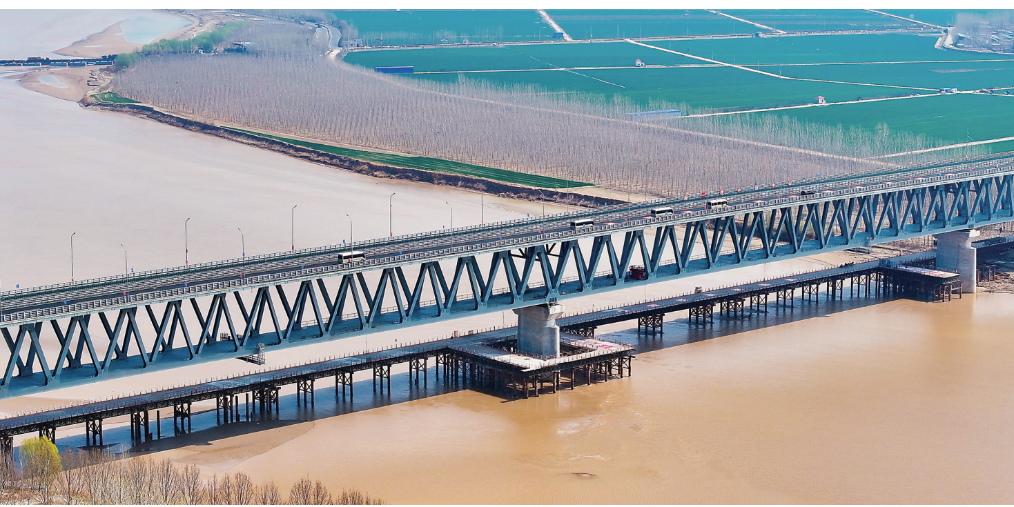
建邦聊泰黄河公铁大桥正式通车
