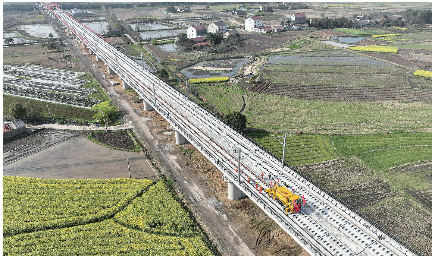
3月28日，牵引车在进行铺轨作业（无人机照片）。
