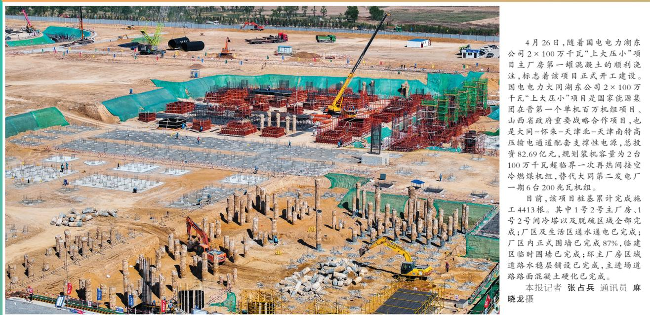
4月26日，随着国电电力湖东公司2×100万千瓦“上大压小”项目主厂房第一罐混凝土的顺利浇筑，标志着该项目正式开工建设。国电电力大同湖东公司2×100万千瓦“上大压小”项目是国家能源集团在晋第一个单机百万机组项目、山西省政府重要战略合作项目，也是大同-怀来-天津北-天津南特高压输电通道配套支撑性电源，总投资82.69亿元，规划装机容量为2台100万千瓦超临界一次再热间接空冷燃煤机组，替代大同第二发电厂一期6台200兆瓦机组。
